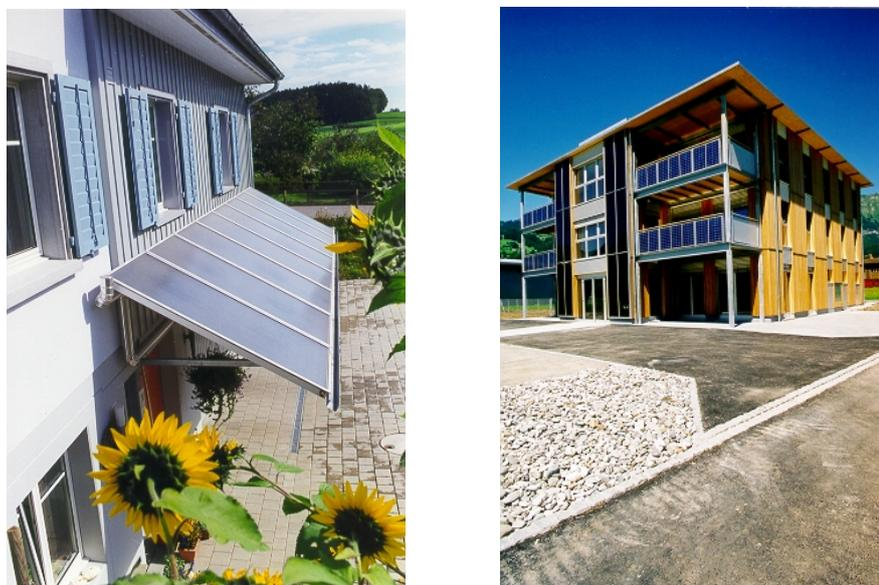
Figura 4: A sinistra, 14.4 m<sup>2</sup> di collettori solari integrati in facciata [SSES, Autore: Heizplan AG, 9450 Altstätten]. A destra, 61 m<sup>2</sup> di collettori solari integrati in facciata [SSES, Autore: Schibli Peter, Heizplan AG, 9473 Gams].
