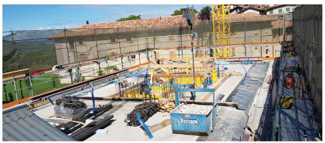
Soletta del secondo piano con al centro il vano dell'ascensore e delle scale.
